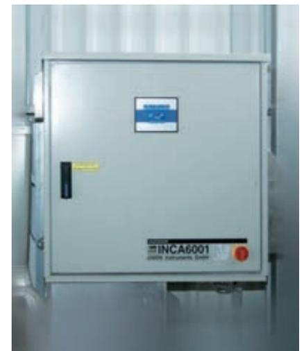
$H_2S$  wird das Biogas in einer biologischen Entschwefelung nachbehandelt. Dabei wird  $H_2S$  durch Bakterien in Schwefelsäure umgewandelt. Der dafür benötigte Sauerstoff wird als Luft über ein Gebläse zugeführt. Durch die Messung des Sauerstoffgehaltes im gereinigten Biogas wird die optimale Versorgung der Bakterien sichergestellt und gleichzeitig verhindert, dass sich durch eine Überversorgung ein explosives Gemisch bilden kann.
